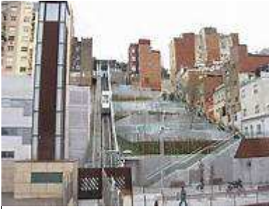
Ascensor inclinat del Carrer Alguer
